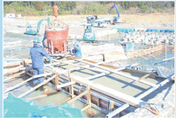
河川改修工事
