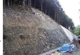
②ラス張・ピッチ割り
