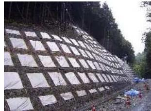
⑦枠内養生シート設
