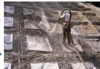
⑧法枠モルタル吹付
