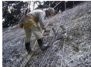
⑤2段目鉄筋、アンカー設置
