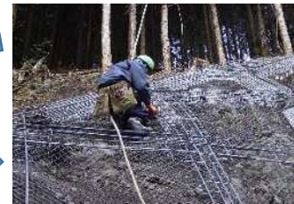
⑥モルタル、ダレ防止補助網設
