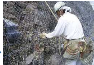
④RTフレーム設置
