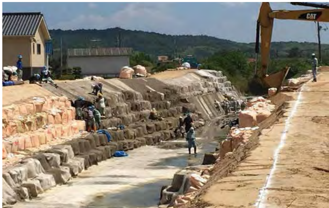
西日本豪雨 仮 末政川堤防決壊応急復旧（岡山県真備町）
