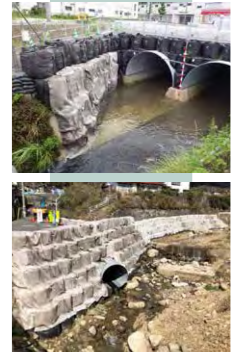
土のう被覆工
