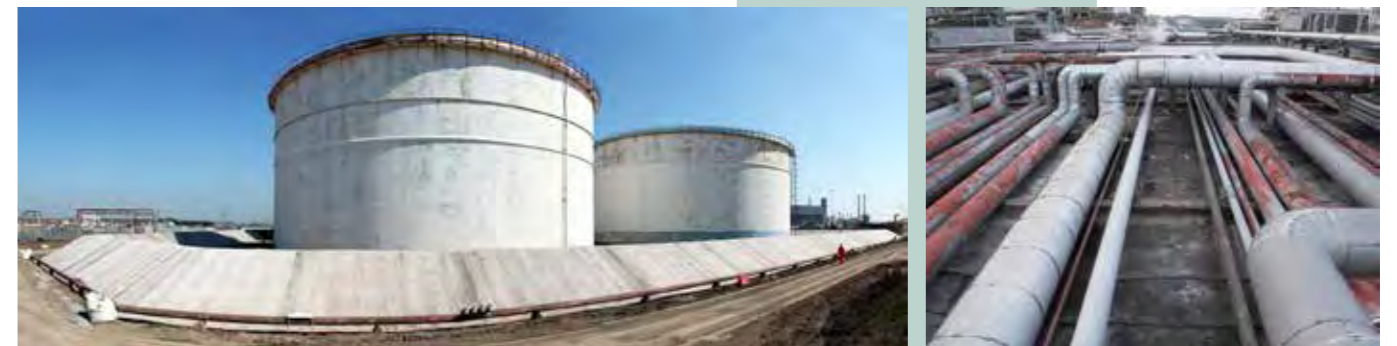
工場施設内 被覆工
