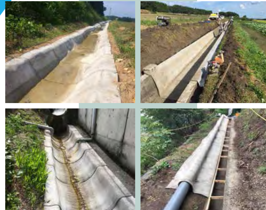
水路工・水路補修工
