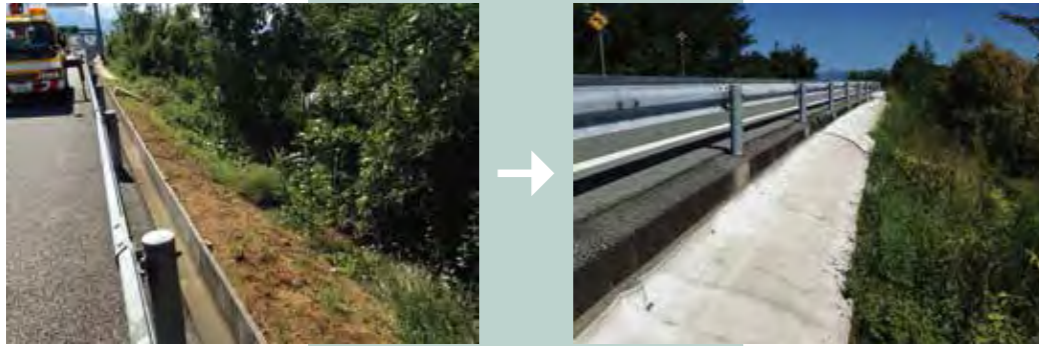
法面保護・防草防竹工
