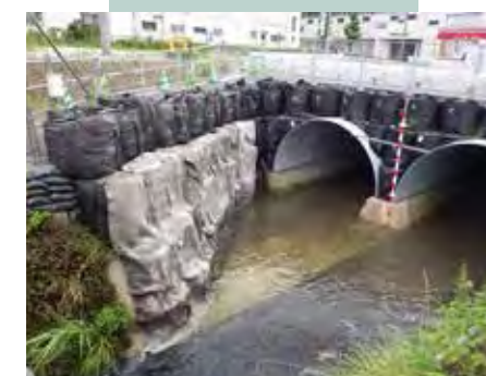
土のう被覆工
