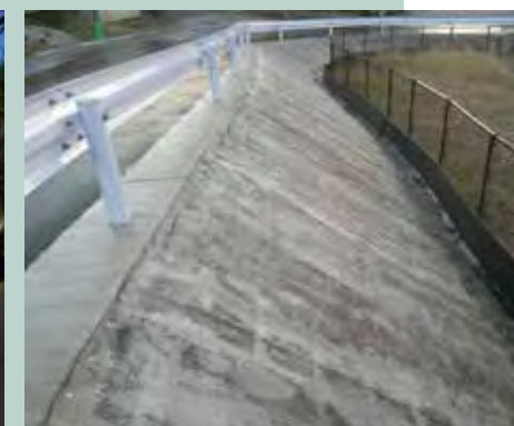
法面保護工・防草工・鳥獣掘起し対策工
