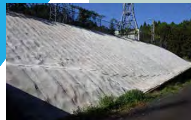
法面保護工・防草工・鳥獣掘起し対策工
