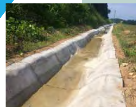
水路工・水路補修工
