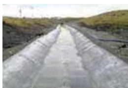
三面張水路工 (大断面)
