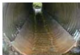
管路ライニング工
