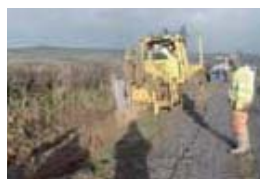
ケーブル保護工
