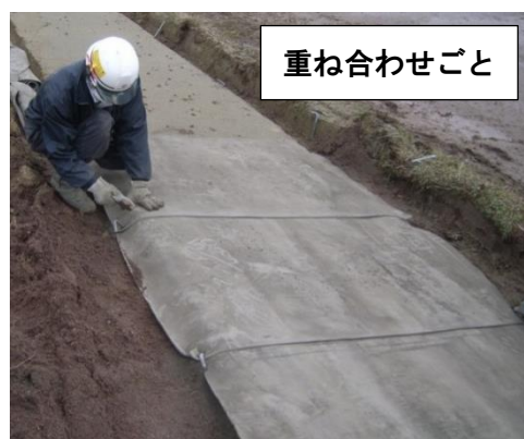
写真-23 CC 重ね合わせごと打設
