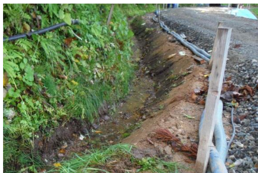
写真-7 整地状況(水路工)
