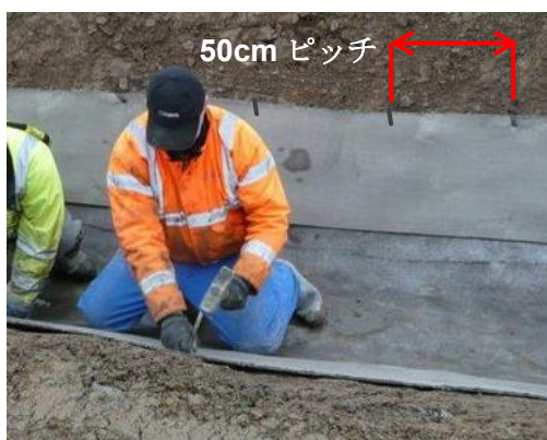
写真-22 50cm ピッチで打設(縦断方向敷設)
