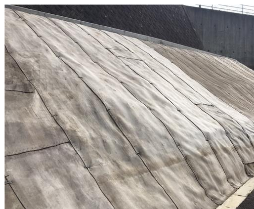
写真-6 敷設後(法面保護工)
