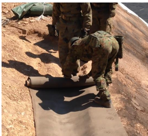
写真-15 縦断方向への敷設
