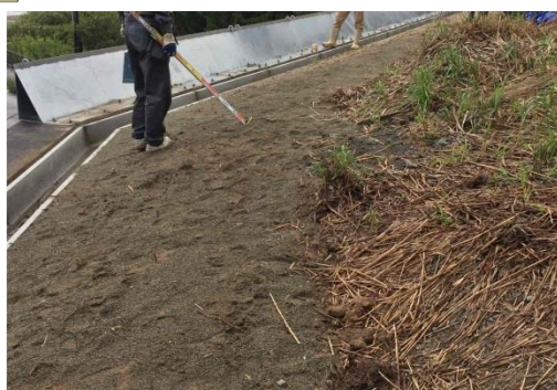
写真-3 整地状況(防草工)
