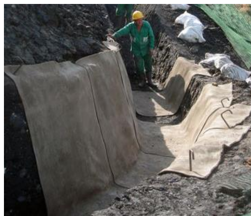
写真-16 横断方向への敷設
