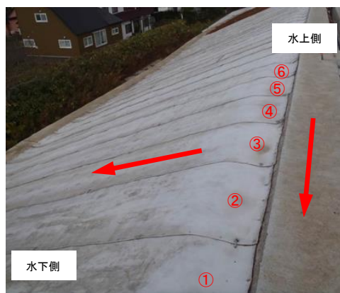
写真-11 縦断方向への敷設
