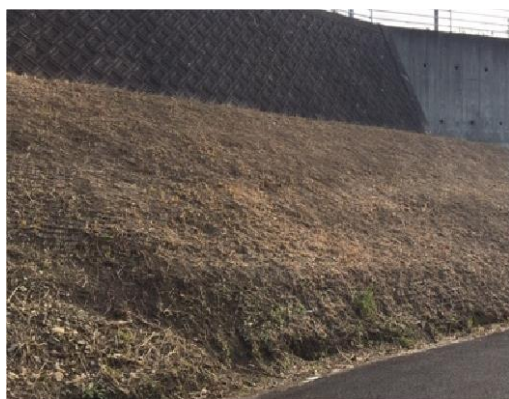
写真-5 整地状況(法面保護工)
