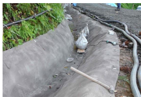
写真-8 敷設後(水路工)
