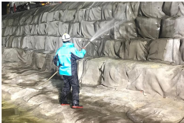
写真-27 水和作業(散水)状況
