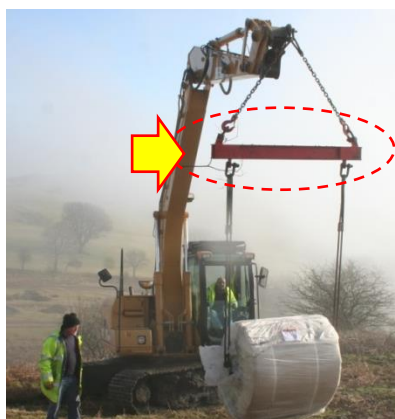
写真-10 敷設治具(左:スプレッダー、右:単管)
