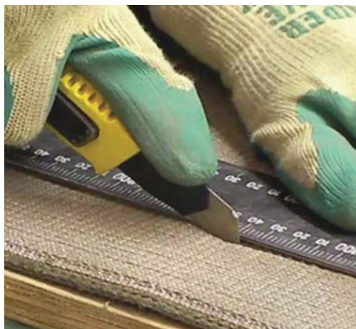
写真-17 カッターによる切断
