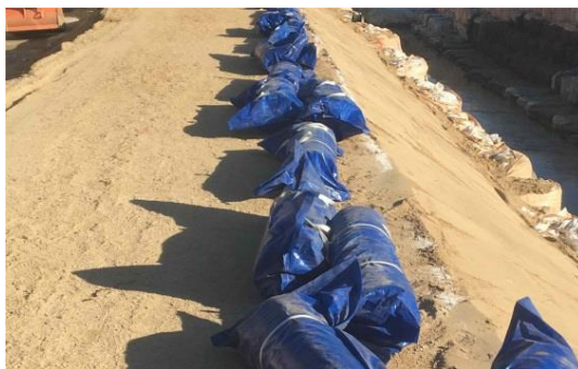
写真-9 バッチロール配置状況
