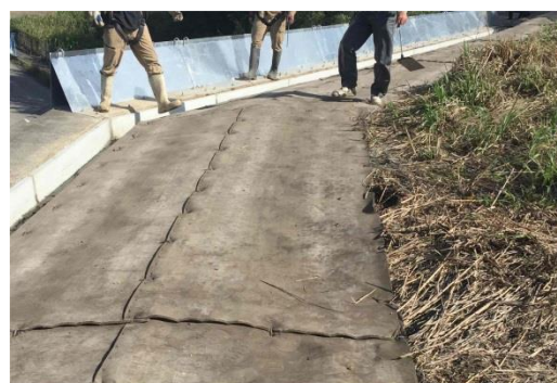
写真-4 敷設後(防草工)
