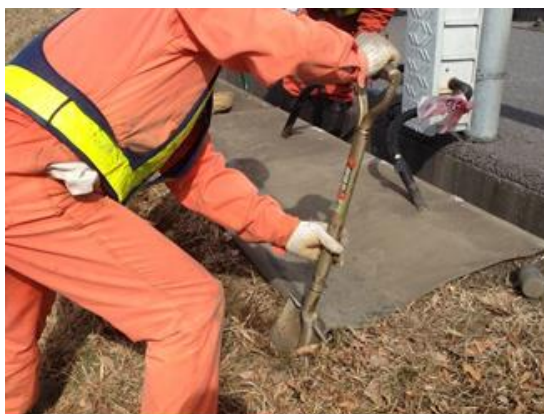
写真-24 洗掘対策状況
