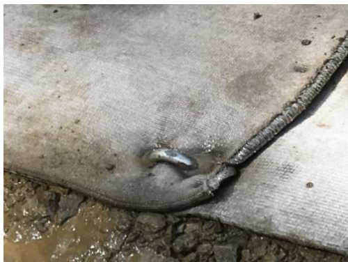
写真-18 アンカーピン打設状況
