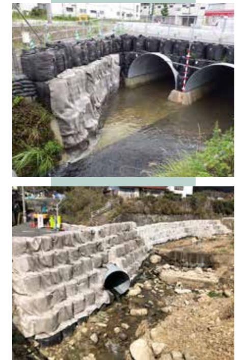
土のう被覆工
