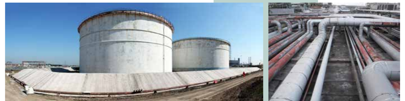
工場施設内 被覆工
