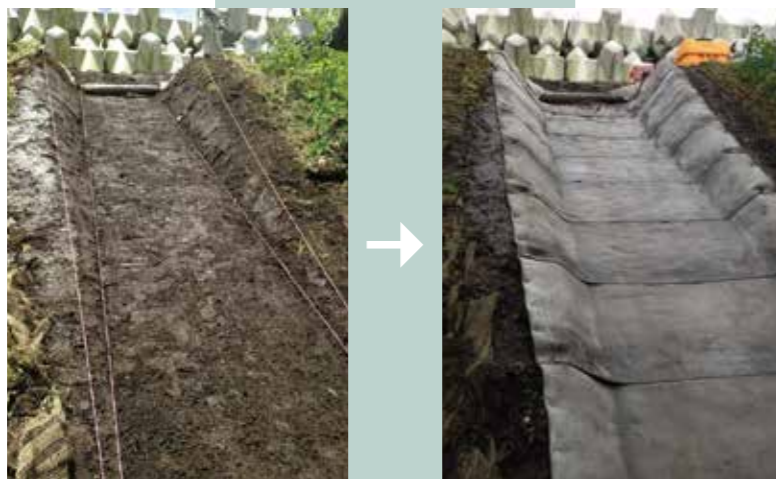
吐水口侵食防止工
