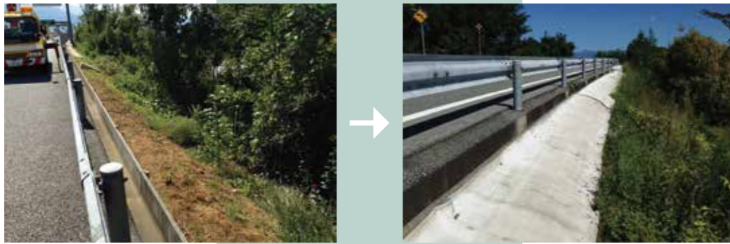
法面保護・防草防竹工
