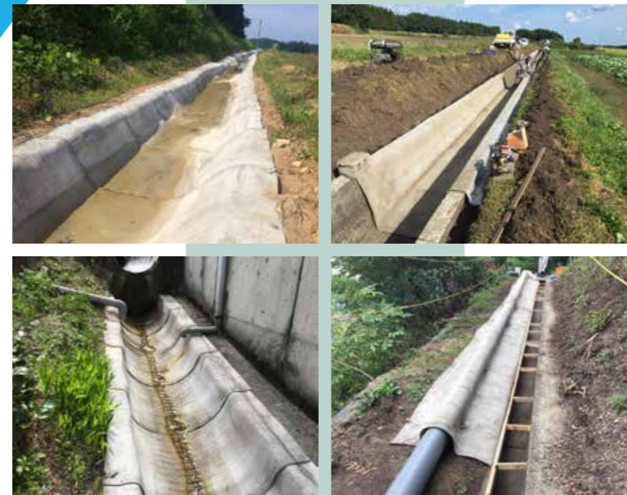
水路工・水路補修工
