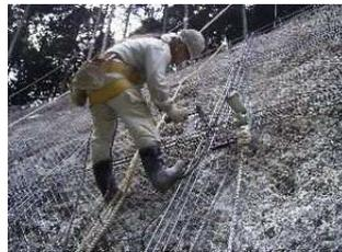
⑤2段目鉄筋、アンカー設置
