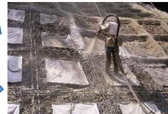
⑧法枠モルタル吹付
