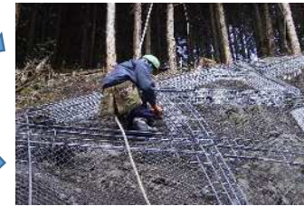
⑥モルタル、ダレ防止補助網設
