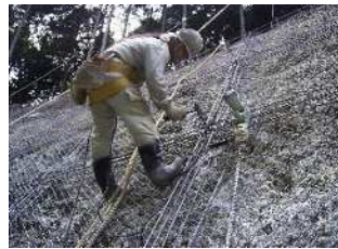
⑤2段目鉄筋、アンカー設置
