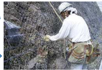
④RTフレーム設置
