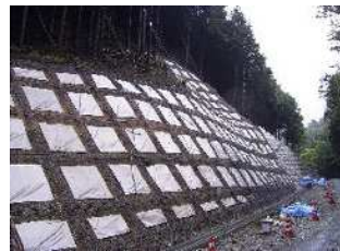
⑦枠内養生シート設
