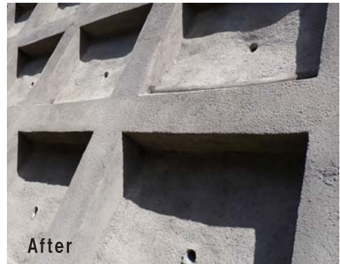
植生からモルタルへ - バルチップ混入モルタル
