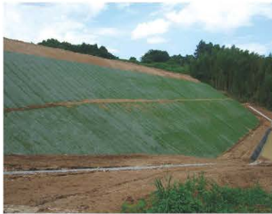
【施工後】 1か月 九州北部豪雨直後
