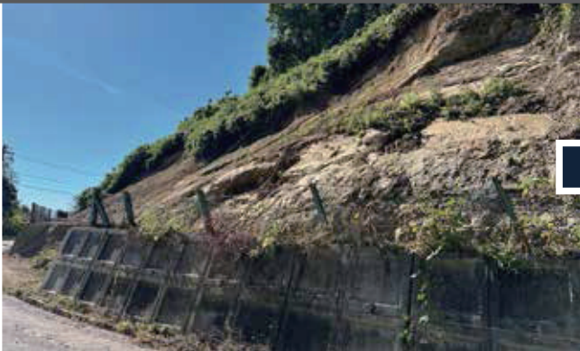
林道法面復旧工事 石川県津幡町 GS-SG-10S
