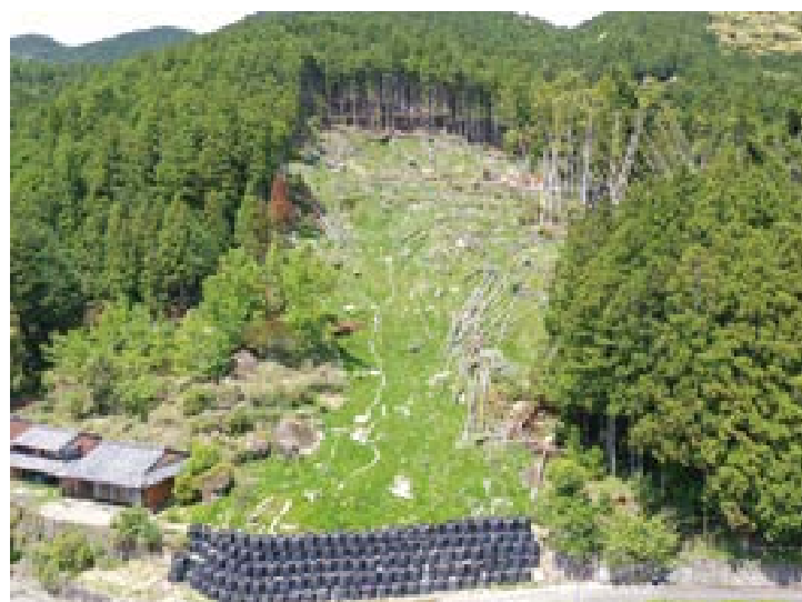
11月の不適期施工にも関わらず、翌年4月には全面緑化により災害跡斜面を保護
