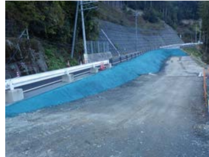
12月の不適期施工
