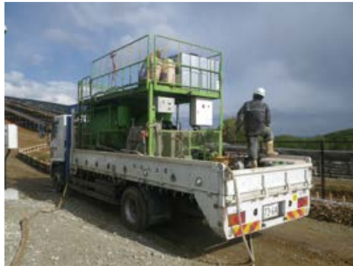
土砂災害対策としてポリソイル緑化工
