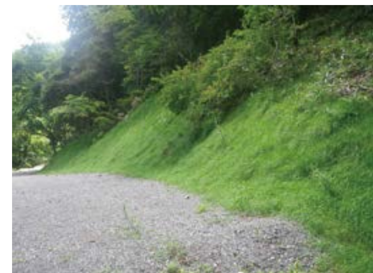
施工後9ヵ月 厳寒地12月の不適期施工にも関わらず、導入植物による全面緑化
