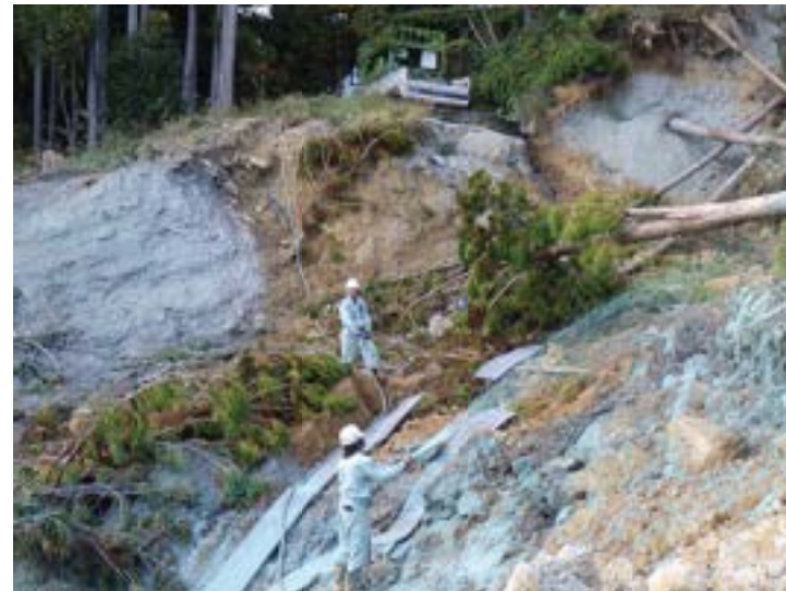
応急対策としてポリソイル緑化工
