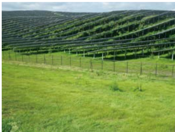
全面緑化によりメガソーラー施設内の土砂災害を防止＋景観性向上
