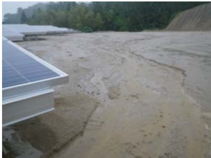
雨が降るたびに土砂が浸食され流出していた
