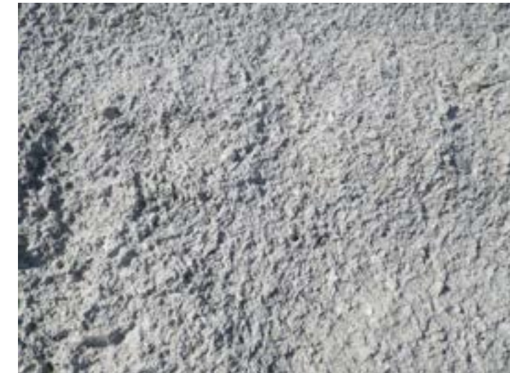
土砂法面がコーティングされた状態。豪雨でも流されない
