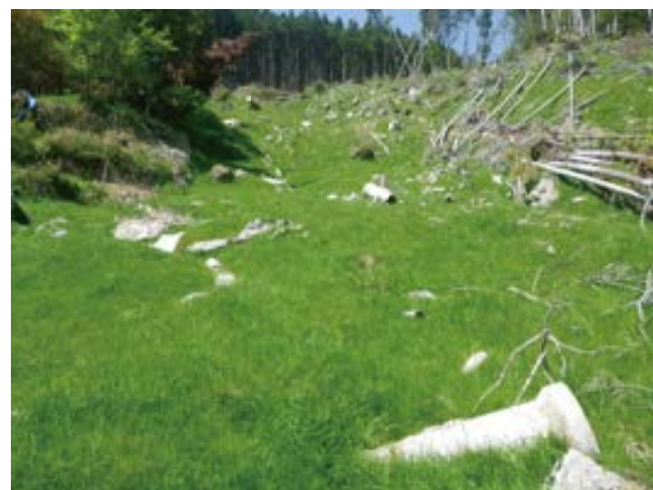
11月の不適期施工にも関わらず、翌年4月には全面緑化により災害跡斜面を保護
