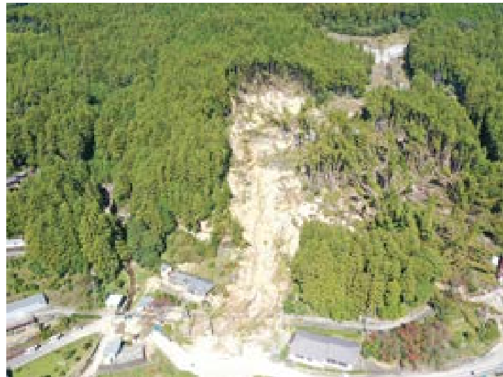
台風の豪雨によって山腹崩壊が発生
