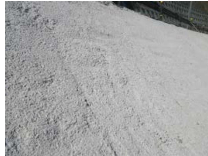
土砂法面がコーティングされた状態。豪雨でも流されない
