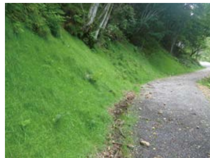
施工後9ヵ月 厳寒地12月の不適期施工にも関わらず、導入植物による全面緑化
