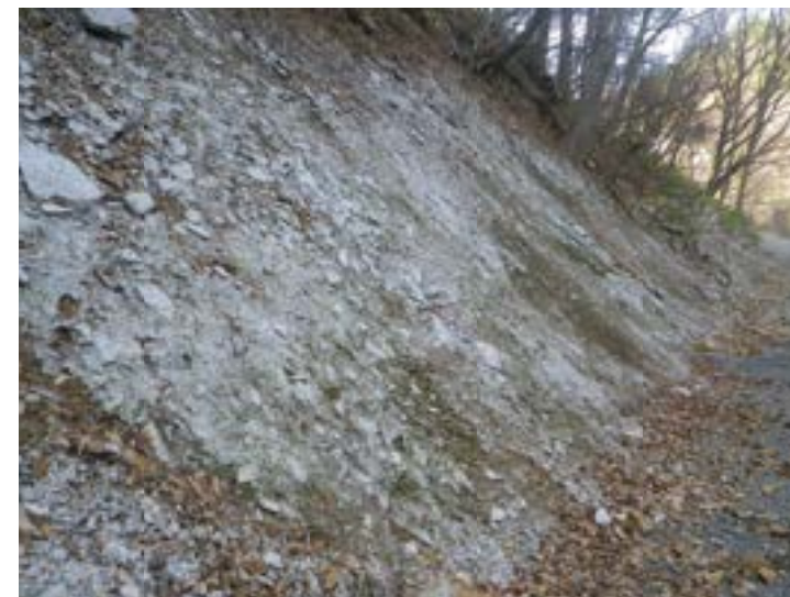
翌年4月 施工後5ヵ月
