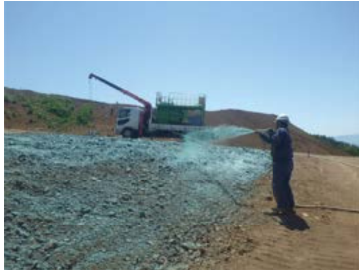
タンクに水と各種材料を調合後、土壌表面に吹き付ける
