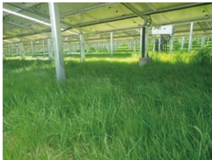
全面緑化によりメガソーラー施設内の土砂災害を防止＋景観性向上
