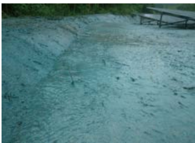
施工後 3 日目での大雨でも全く流されず
