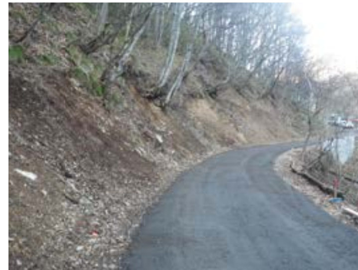
長野県菅平高原近くの道路法面
