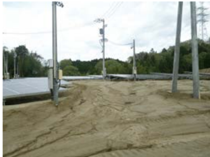
雨が降るたびに土砂が浸食され流出していた
