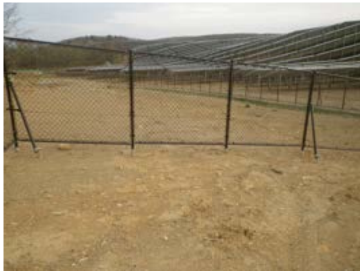
緩やかな傾斜地でも土砂災害が発生
