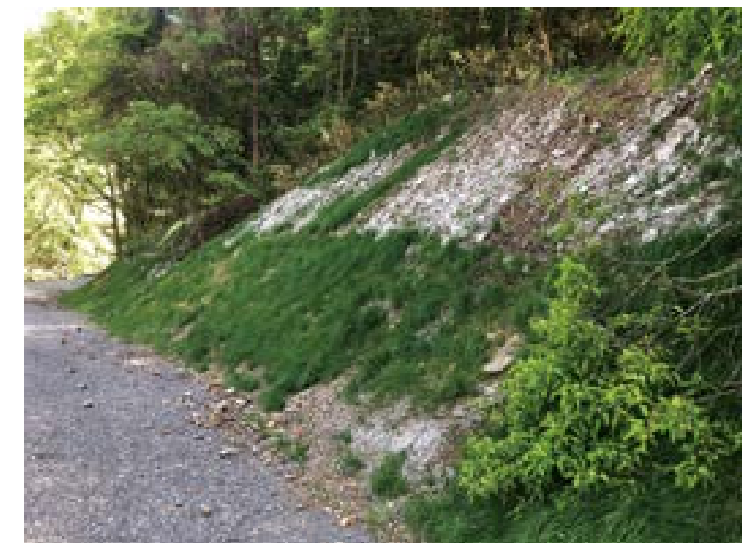
翌年6月 施工後7ヵ月
