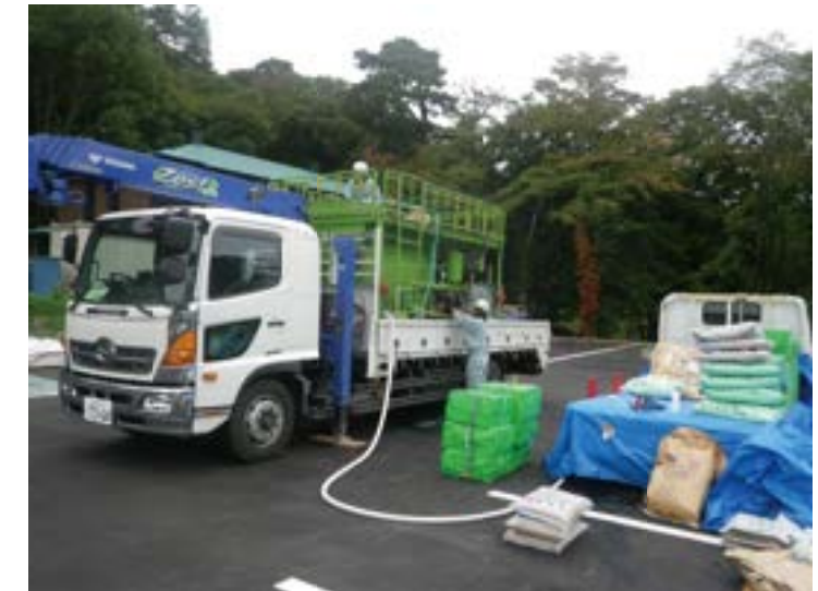
施設内駐車場からホース延長
