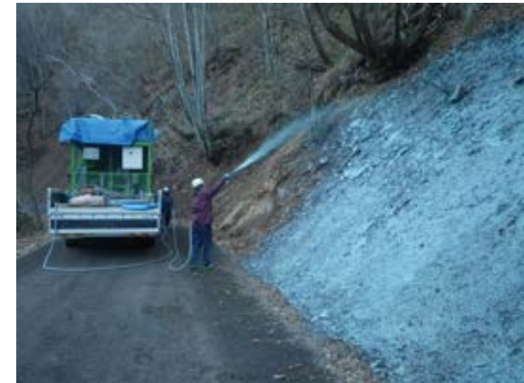
12月中旬の不適期施工
