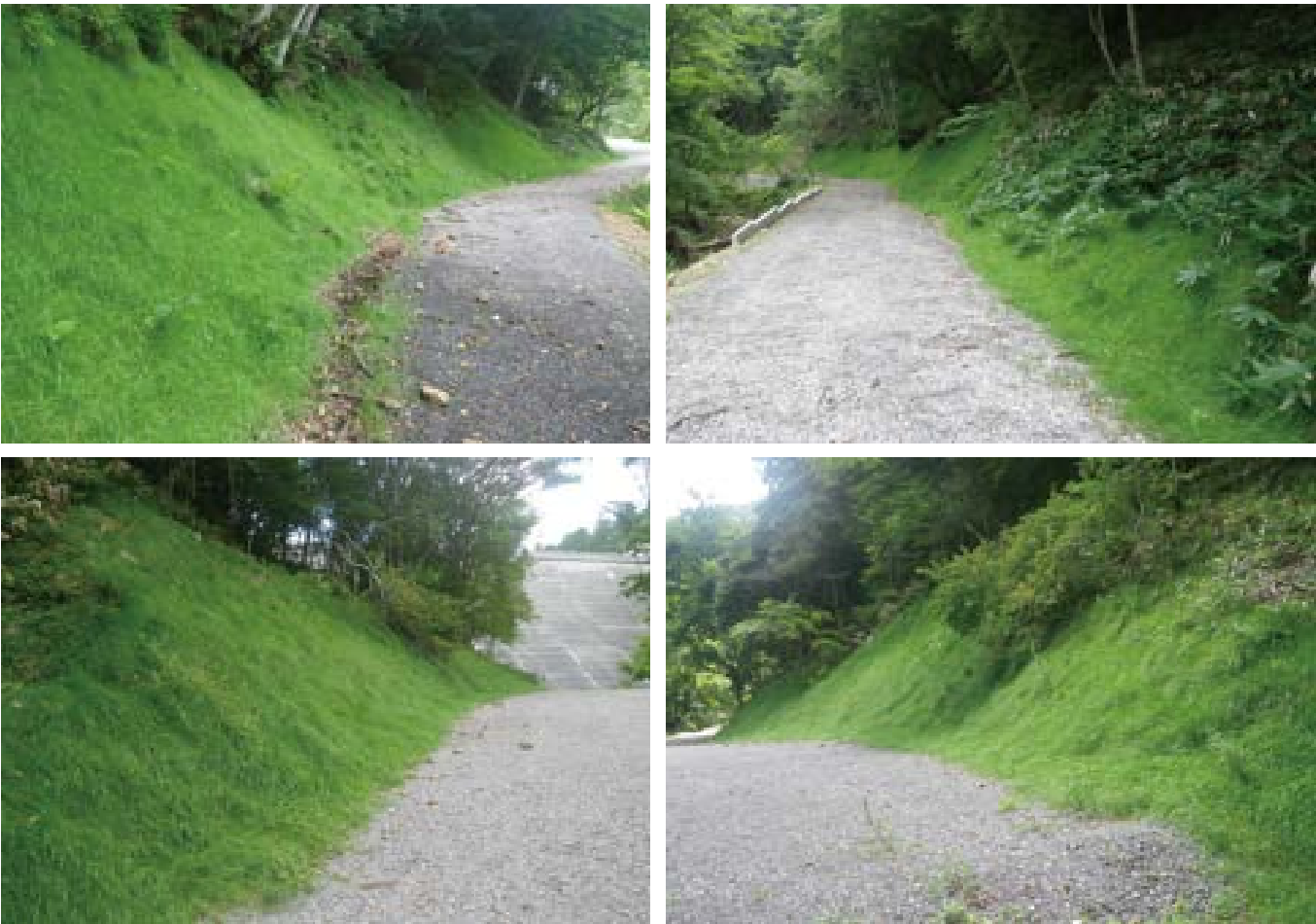
厳寒地での不適期施工にも係わらず、全面緑化となりました。
