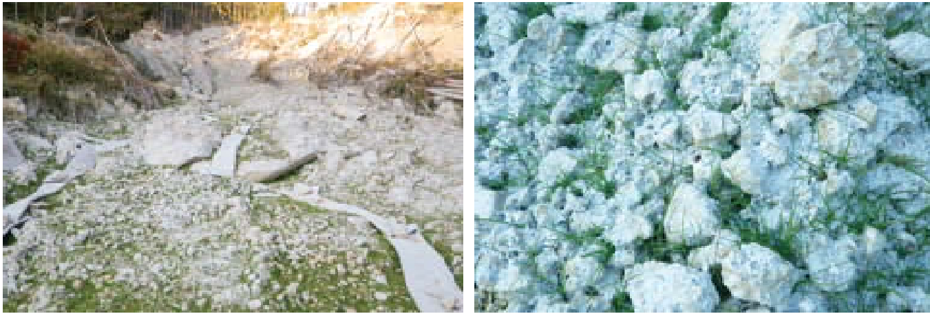
施工後1ヵ月で発芽を確認。緑化基盤はしっかり残っています。
