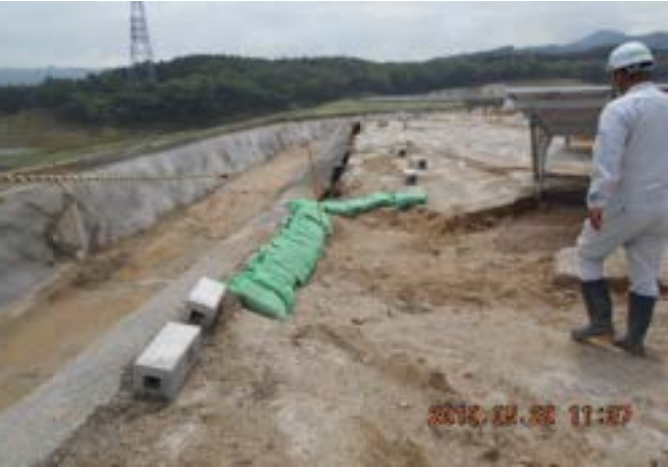
ほとんど平面ではありますが、降雨による表面水で土砂が流出していました。
