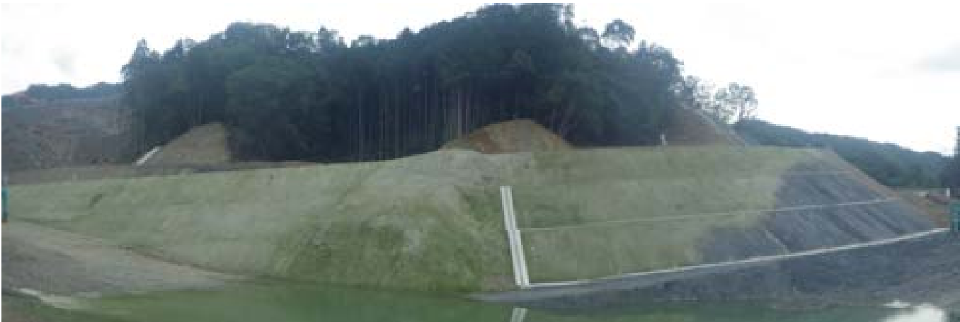
大規模造成工事の切土及び盛土法面でポリソイル緑化工が採用されました。
