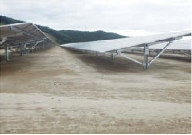
ほとんど平面ではありますが、降雨による表面水で土砂が流出していました。
