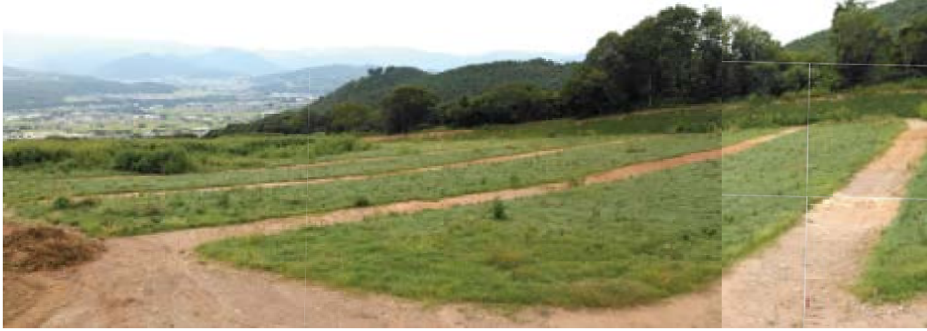
ポリソイル緑化工によって土壌の浸食防止効果が発揮されています。
