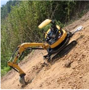
掘削（レキ質土）
