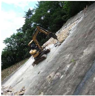
既設モルタル取壊
