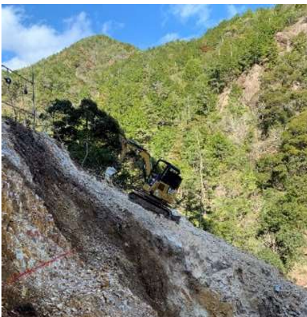
目的 高規格道路 施工地 愛知県 発注機関 国
