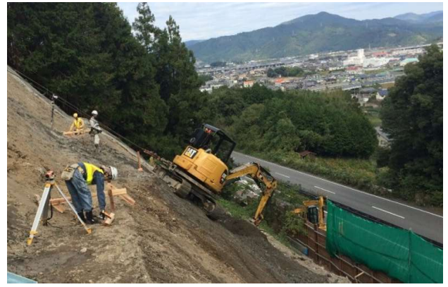
目的 道路 施工地 静岡県
