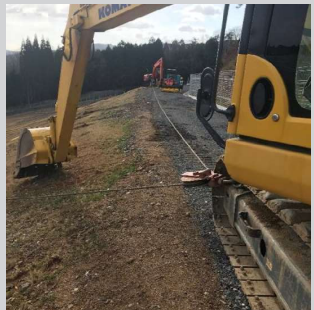
重機アンカー
