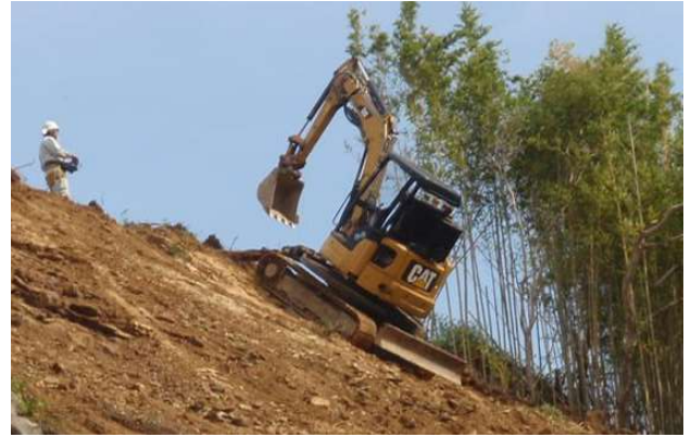
目的 急傾斜 施工地 和歌山県
