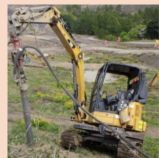
先行削孔 ダウンザホールハンマー
