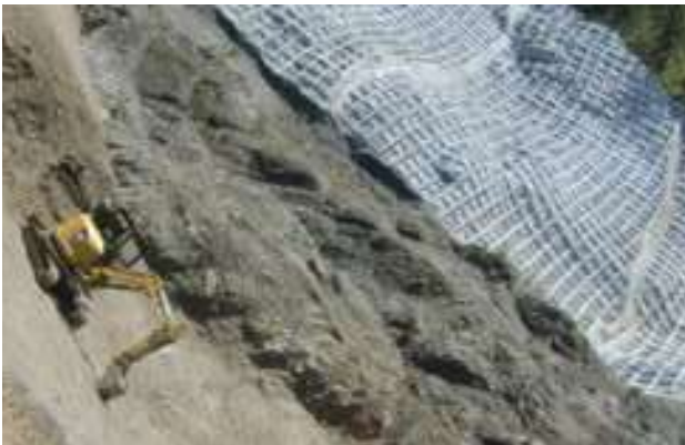
目的 治山 施工地 静岡県 発注機関 国
