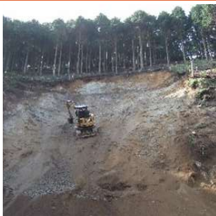
法面整形（レキ質土）
