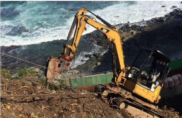
目的 道路 施工地 福岡県
