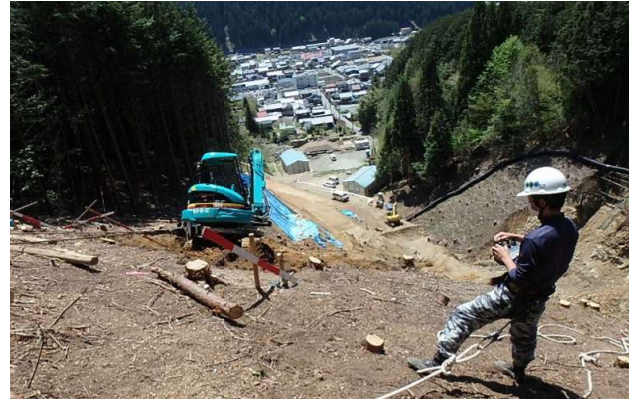
目的 砂防 施工地 岐阜県
