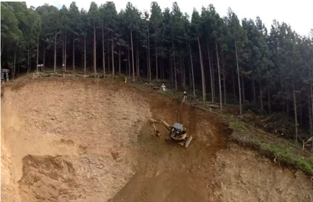
目的 治山 施工地 山梨県
