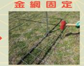
外側金網のスカート部を アンカーで地山に固定 します。
