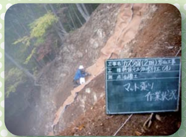
2. ヤシマットネット張り工
